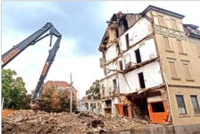
Daimlerstr. 100: Abriss nach jahrelangem Leerstand
